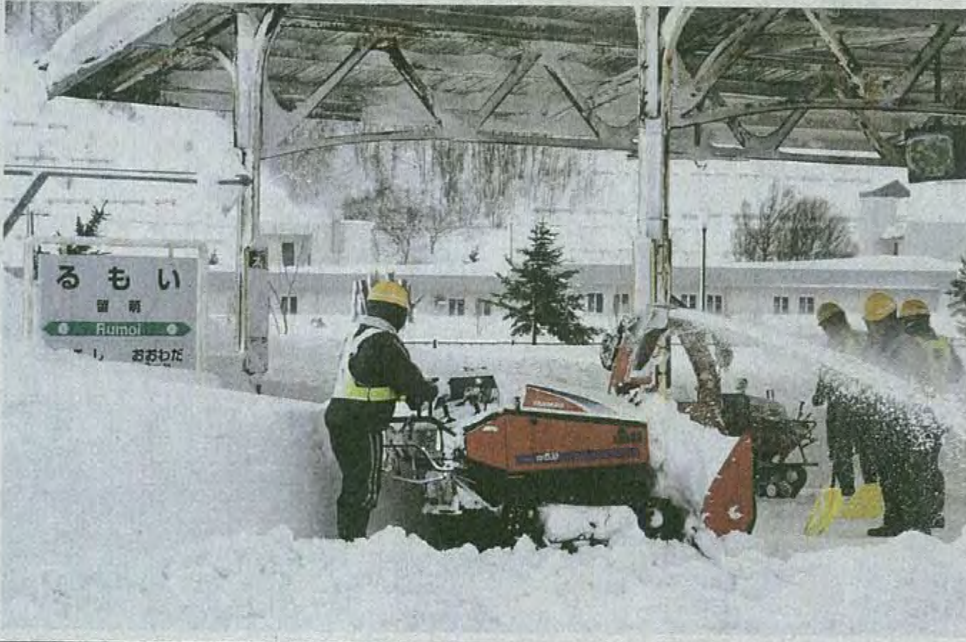
ホームの除雪をする作業員（7日、留萌駅で）＝平田舞撮影
